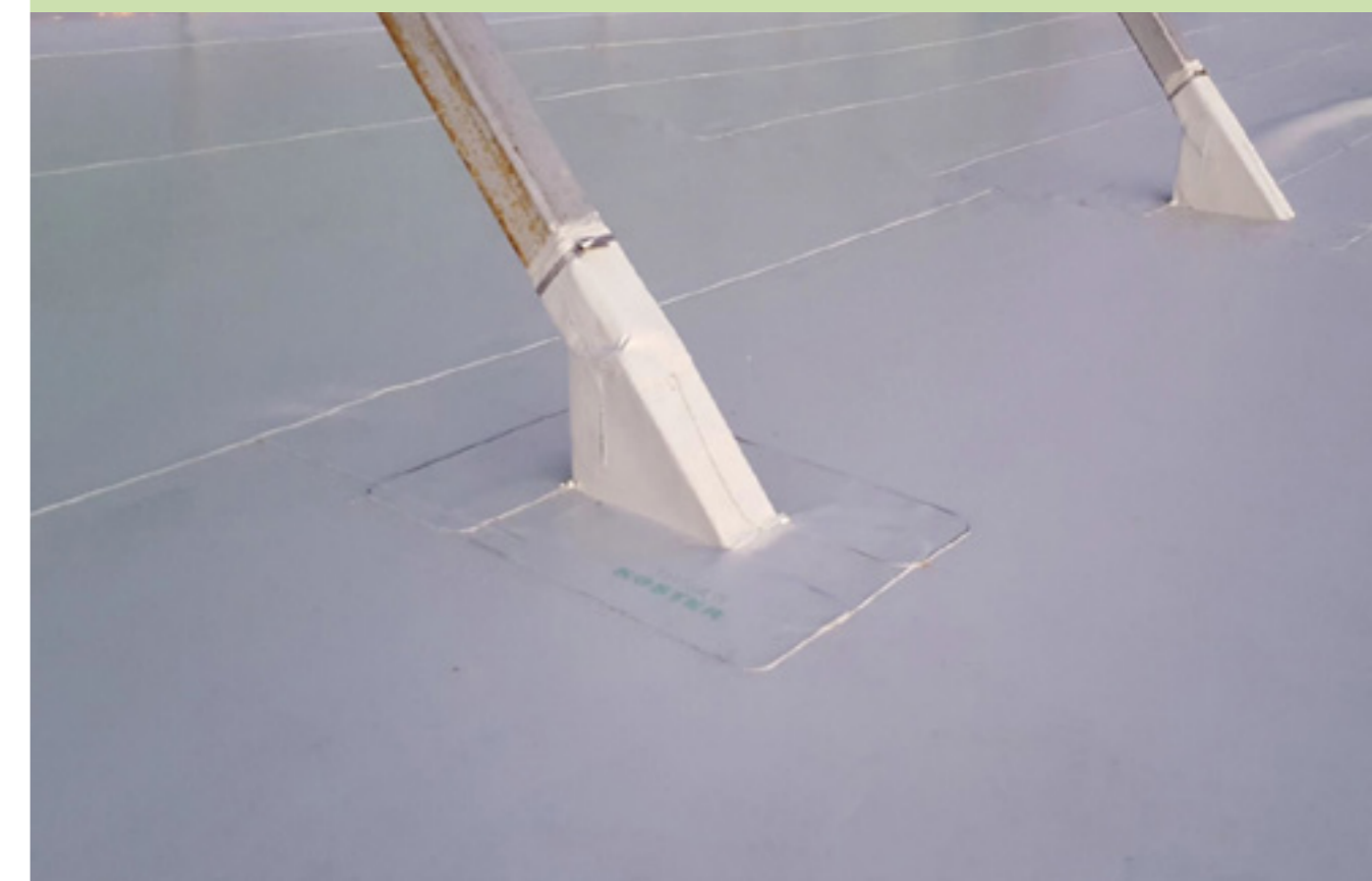
Unión a penetración en ángulo recto
