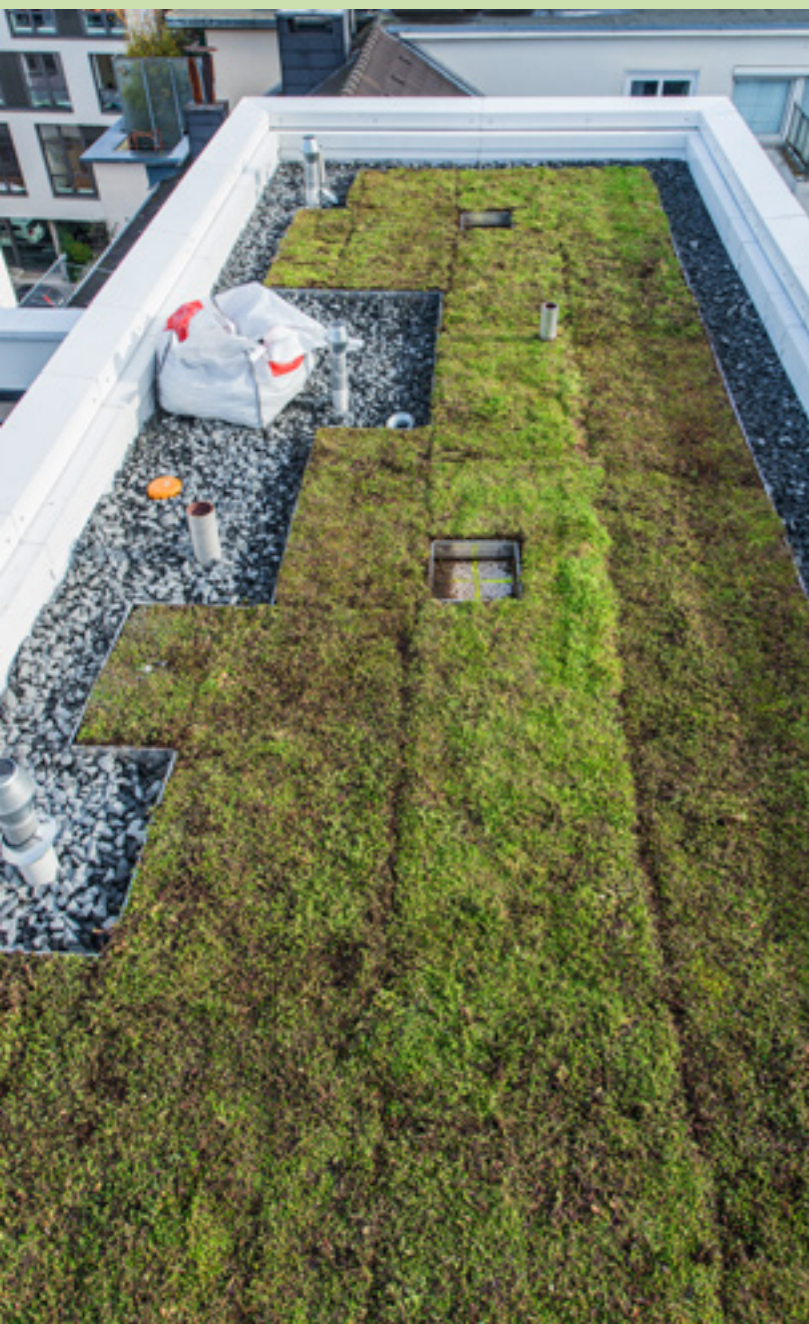
Techo verde extensivo
